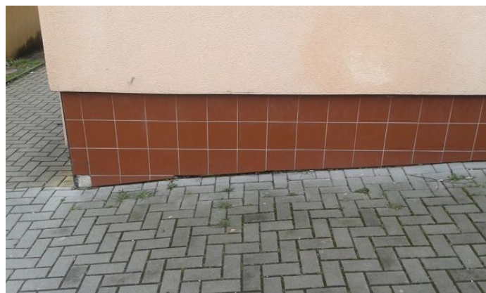
obr. /22/ Chodník z betonové zámkové dlažby na severní straně objektu
