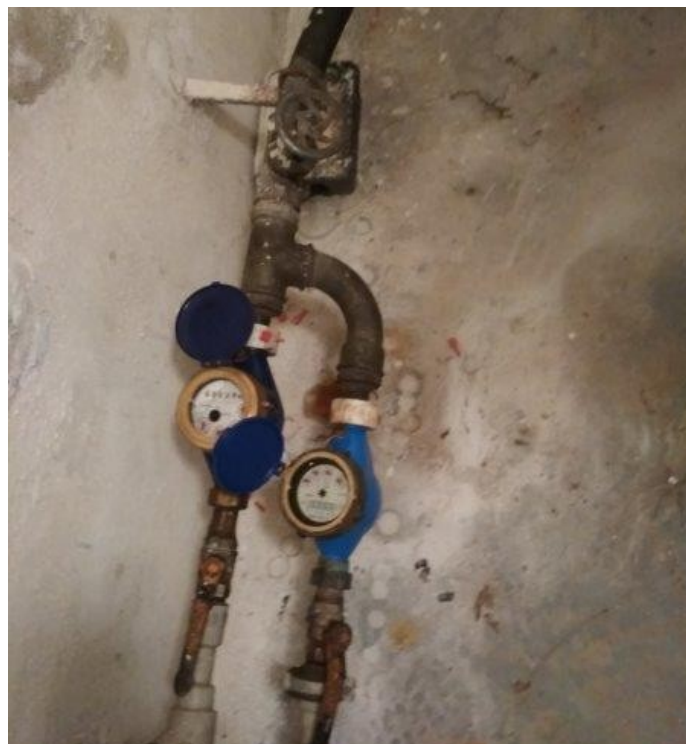
obr. /41/ Vodoměrná sestava
