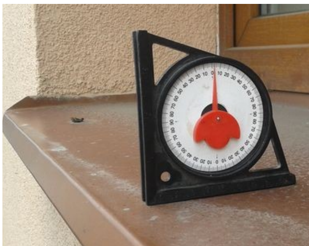
obr. /32/ Nedostatečný sklon parapetu na severovýchodní straně fasády
