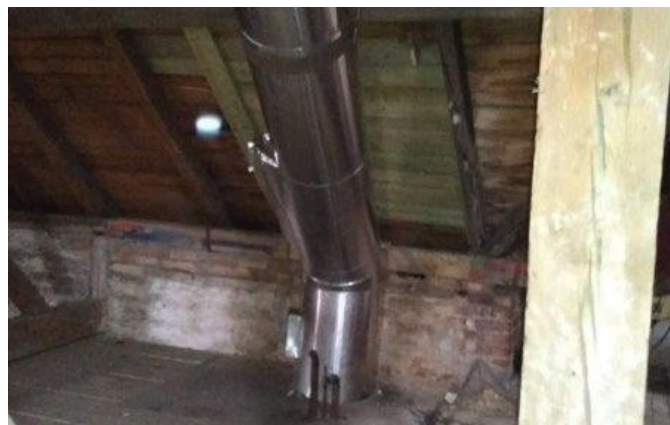
obr. /26/ Nové nerezové komínové těleso
