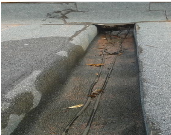
obr. /36/ Pohled na mezistřešní žlab s topnými kabely
