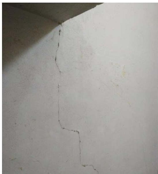
obr. /12/ V místě uložení průvlaku je šikmá trhlina
