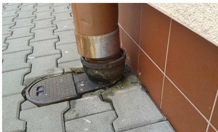
obr. /54/ V místě lapače střešních splavenin je snížená dimenze dešťového odpadního potrubí
