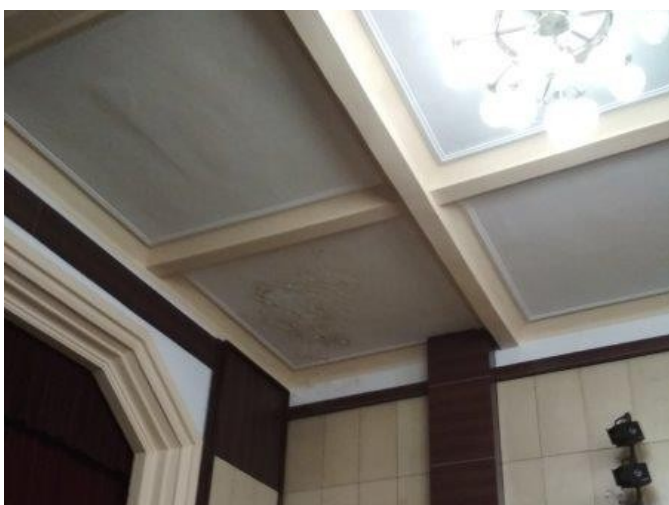
obr. /8/ Ve velkém sále jsou stopy vlhkostních poruch od lokálního zatekání střešním pláštěm
