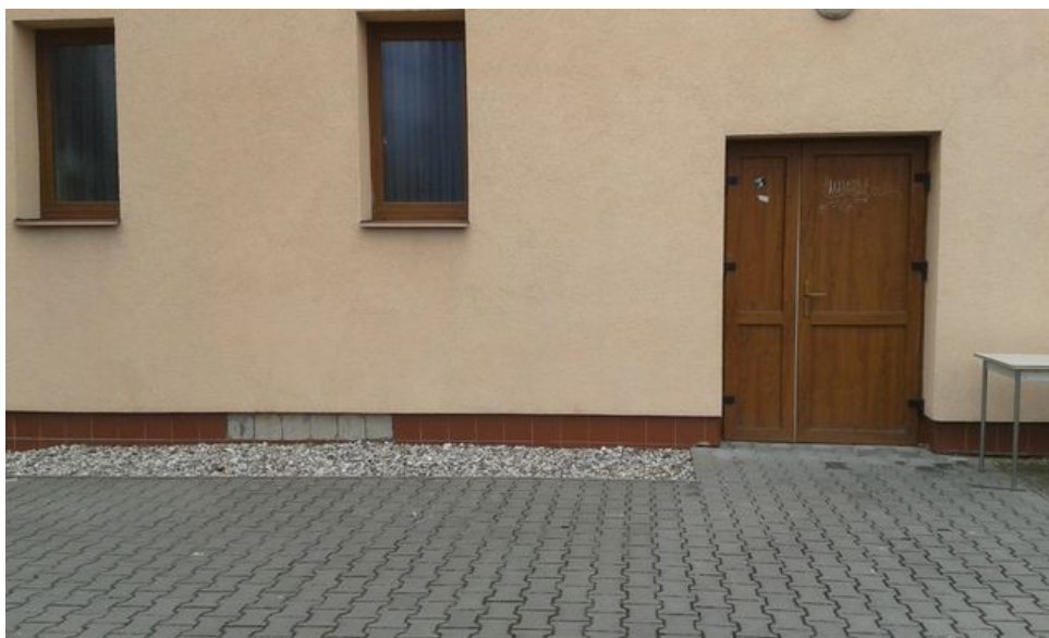
obr. /10/ Opadávající soklový obklad na jihozápadní straně objektu
