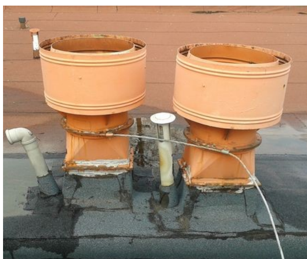
obr. /38/ Prostupy střešním pláštěm – obtížné opracování z důvodu kumulace prostupů
