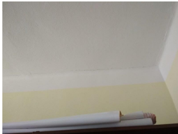
obr. /14/ Trhliny v místě uložení stropní konstrukce na obvodovou stěnu
