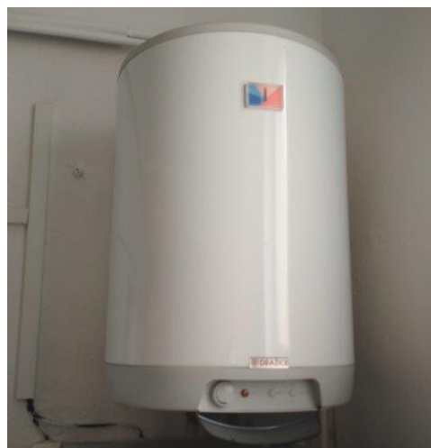
obr. /52/ Pro ohřev teplé vody slouží lokální zásobníkové ohříváče teplé vody
