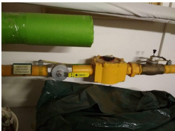
obr. /44/ Rozvod plynovodu opatřený nátěrem žluté barvy
