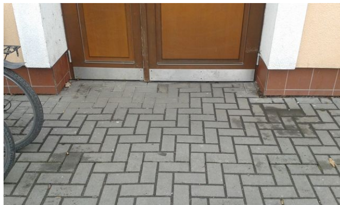
obr. /16/ Ochrana dveří proti mechanickému poškození (okopu) kovovým ochranným pásem
