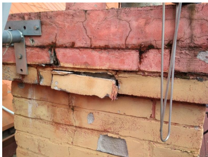
obr. /24/ Z komínového tělesa umístěného na jihovýchodní straně objektu odpadávají kusy zdiva
