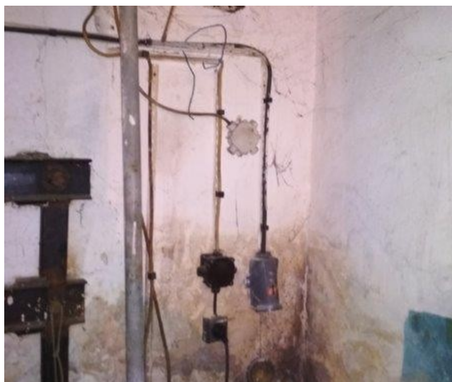
obr. /46/ Původní rozvody elektroinstalace v klubu Peklo
