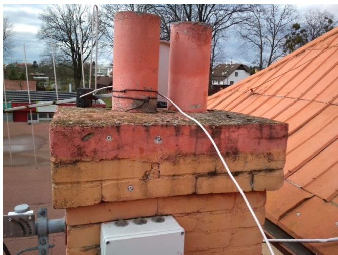
obr. /23/ Ukončení původních komínových těles není chráněno oplechováním, nebo ochranným nátěrem
