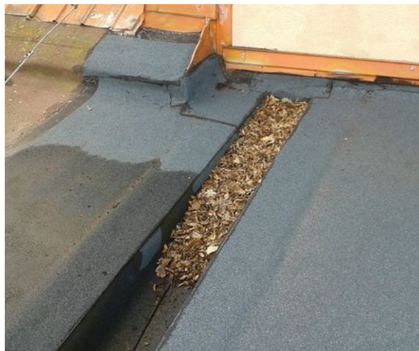
obr. /37/ Zanesení střešního žlabu listím
