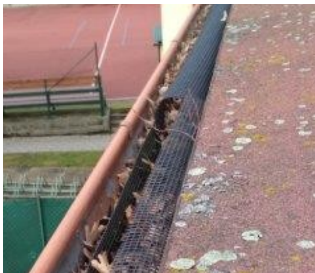
obr. /33/ Podokapní žlaby jsou lehce zaneseny listím
