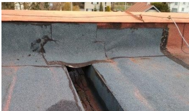
obr. /30/ Vyspravení hydroizolace v místě střešního žlabu
