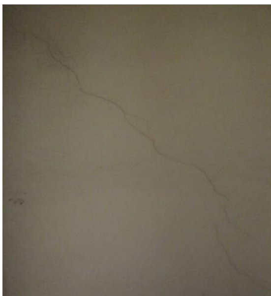
obr. /11/ V zrcadlovém sále se nacházejí šikmé trhliny
