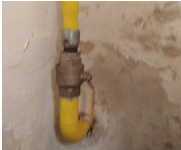
obr. /55/ Hlavní uzávěr plynu je umístěn v suterénu objektu v blízkosti prostupu plynové přípojky suterénní stěnou
