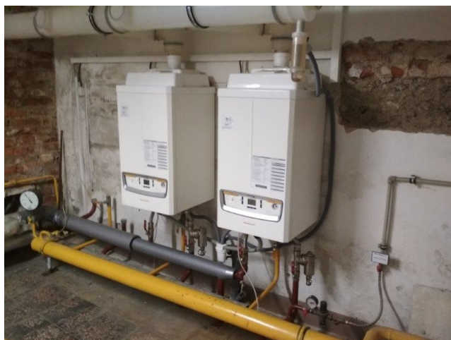
obr. /51/ Zdrojem vytápění je plynový kotel umístěný v suterénu objektu
