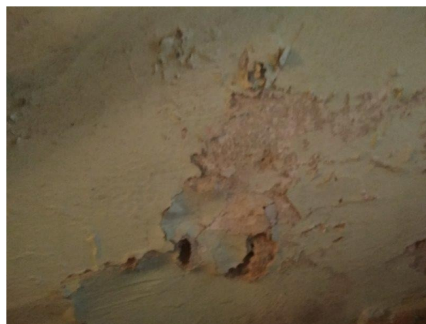
obr. /4/ Na suterénních stěnách se nacházejí vlhké mapy a opadáva omítka vlivem zvýšené vlhkosti obr. /5/ Nesoudržná omítka pod schodišťovým prostorem
