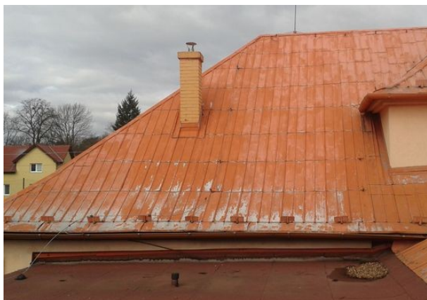
obr. /25/ Průduch původního komínového tělesa je chráněn ochrannou stříškou
