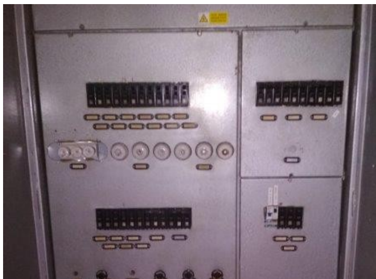
obr. /47/ Původní hlavní uzávěr elektrické energie
