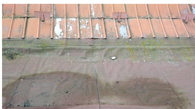
obr. /31/ Stopy biologického napadení povrchu asfaltových pásů
