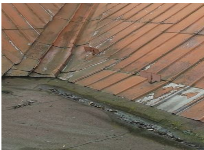
obr. /39/ Zvlnění asfaltových pásů v místě napojení na šikmou střechu – tvorba kaluží
