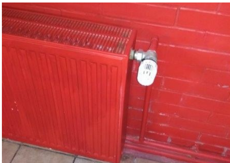
obr. /50/ V klubu Peklo jsou trojitě ocelové deskové radiátory
