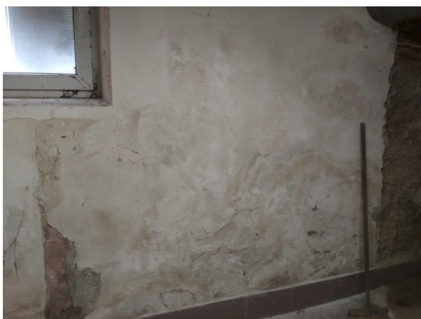
obr. /4/ Na suterénních stěnách se nacházejí vlhké mapy a opadáva omítka vlivem zvýšené vlhkosti obr. /5/ Nesoudržná omítka pod schodišťovým prostorem
