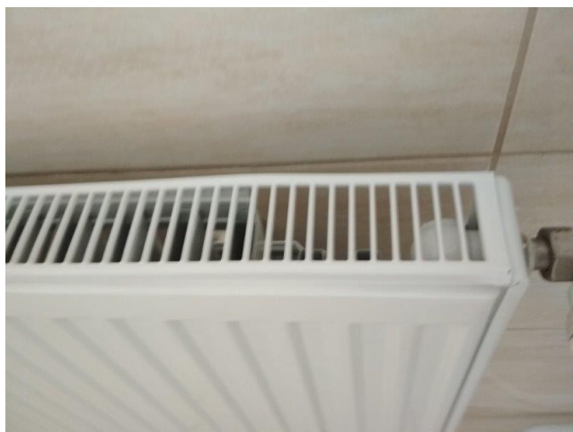
obr. /49/ Ve většině objektu jsou dvojité ocelové deskové radiátory
