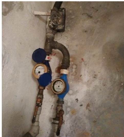
obr. /56/ Při vizuální prohlídce na vodoměrné sestavě chybí vypouštěcí ventil
