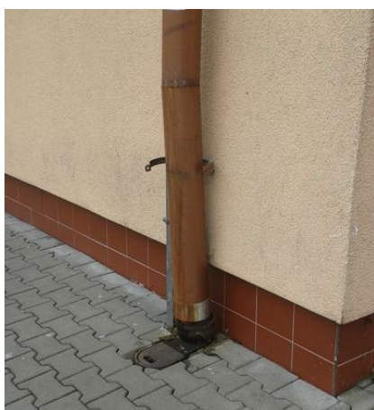
obr. /53/ Objímka střešního svodu je rozevřená a nestabilizuje jeho polohu
