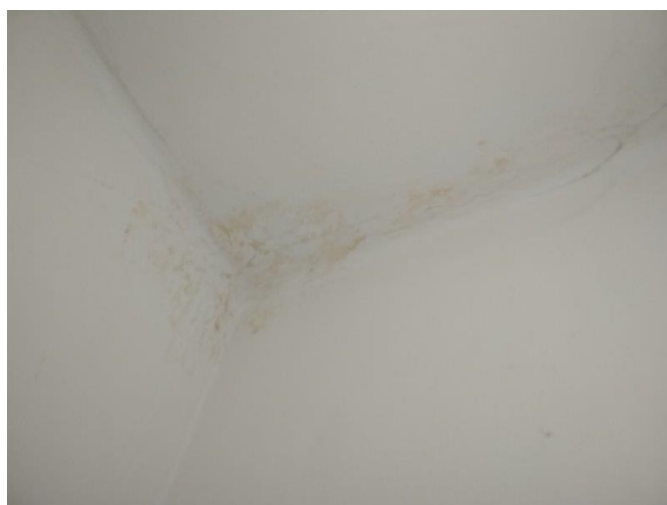
obr. /9/ V rohu malého sálu se nachází stopy vlhkostních projevů
