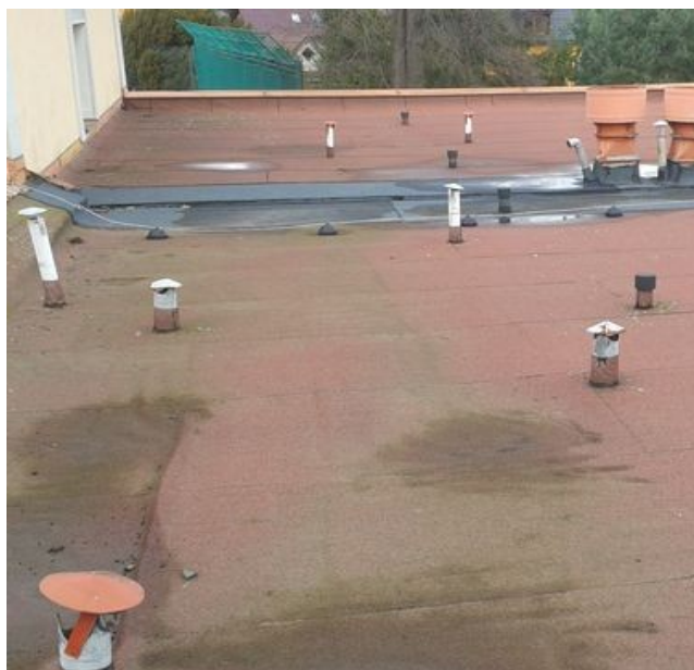
obr. /34/ Vyústění prostupujících potrubí nad střešní plášť – degradace potrubí
