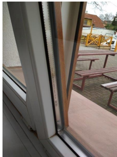
obr. /18/ Prosklená výplň okenních křídel je tvořena izolačními dvojskly s hliníkovým distančním rámečkem.
